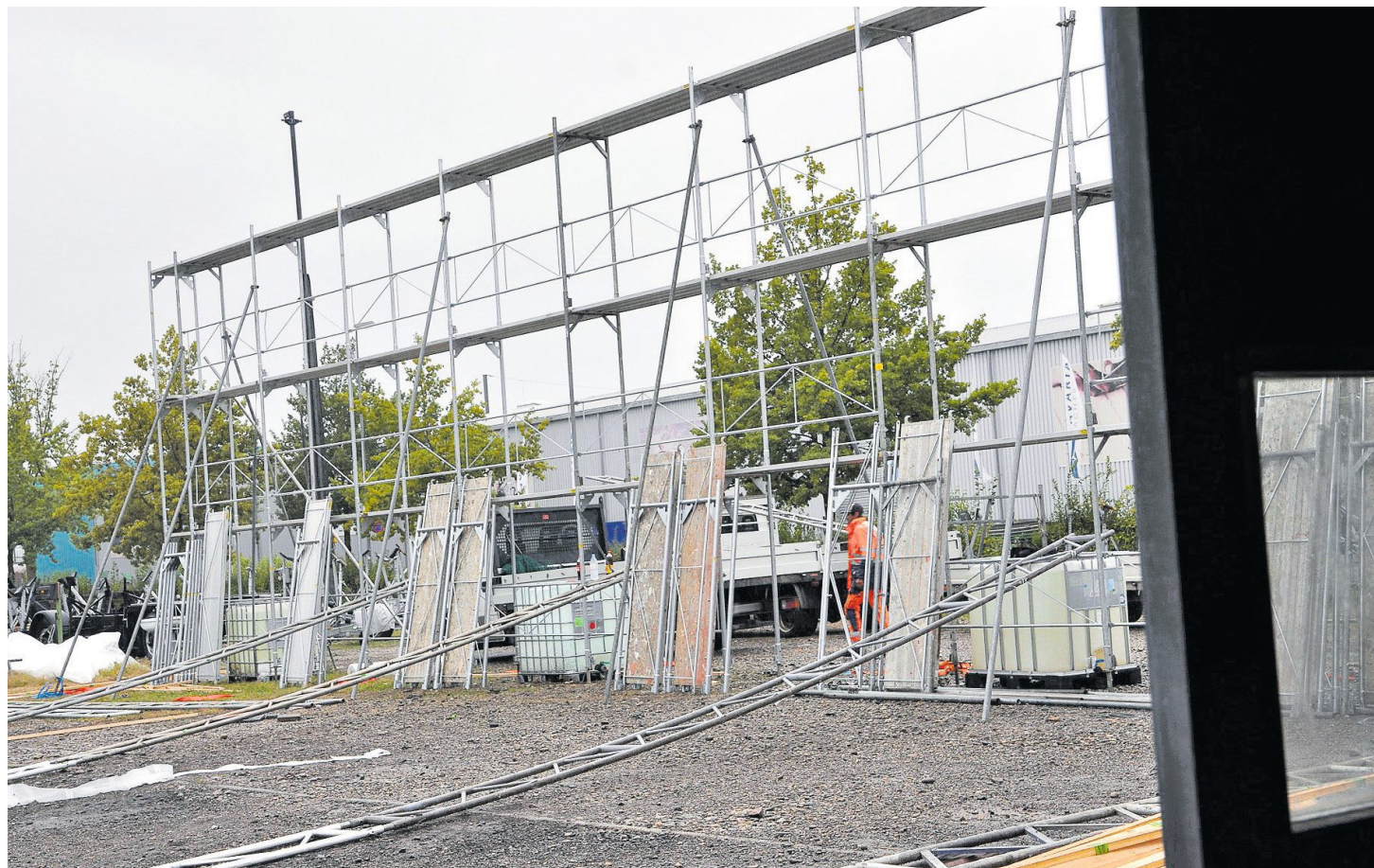
Gestern Nachmittag waren Arbeiter damit beschäftigt, das Zeltgerüst abzubauen.
